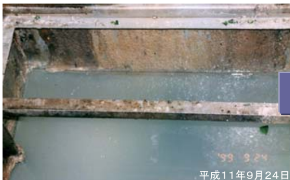
設置前の汚水枡の状態
