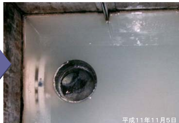
設置後の汚水枡の状態
