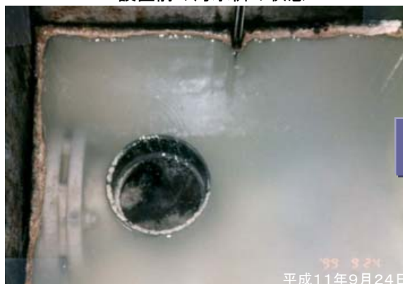
設置前の汚水枡の状態
